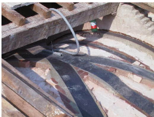
Fig. Voltine a padiglione. Placcaggio estradossole con reti polimeriche Voltine a crociera. Rinforzo estradossole con nastri FRP.
