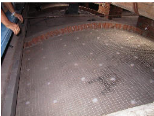
Fig. Voltine a padiglione. Placcaggio estradossole con reti polimeriche Voltine a crociera. Rinforzo estradossole con nastri FRP.
