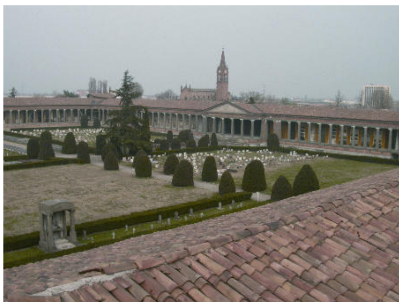
Vista panoramica del camposanto di S. Cataldo dal tetto
