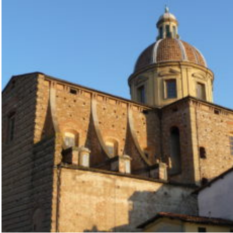
Firenze, Chiesa di Cestello.
